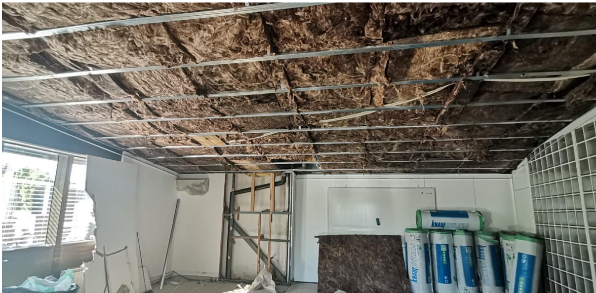
Učilnica 4 v času obnove.
