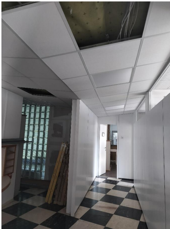
Hodnik po obnovi pred pleskanjem sten.
