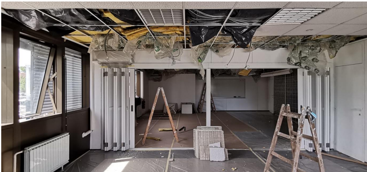
Učilnica 5 v času obnove.
