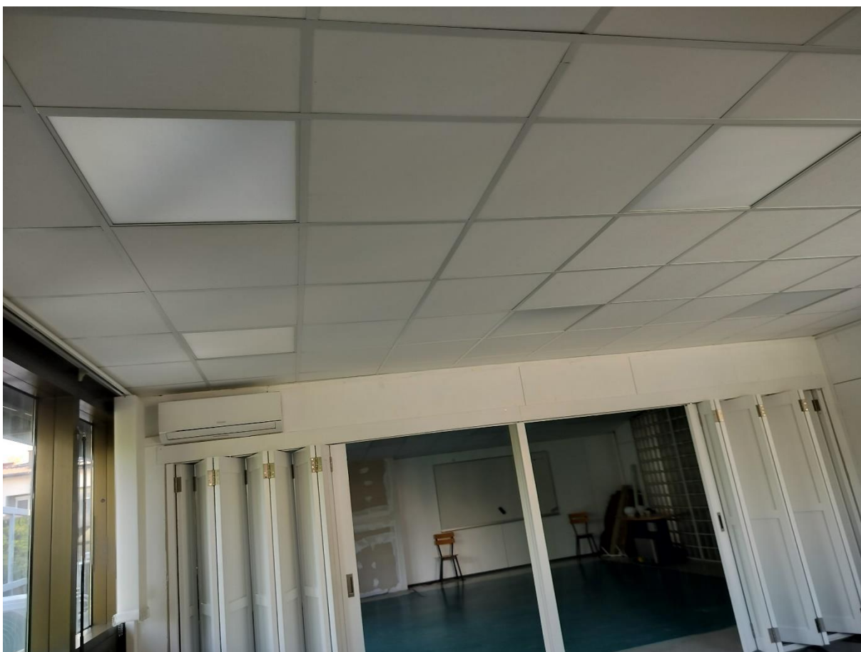
Učilnica 5 po stropni obnovi pred pleskanjem sten.
