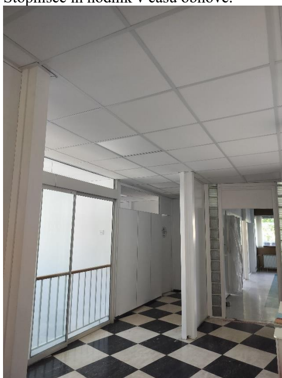
Hodnik po stropni obnovi pred pleskanjem sten.
