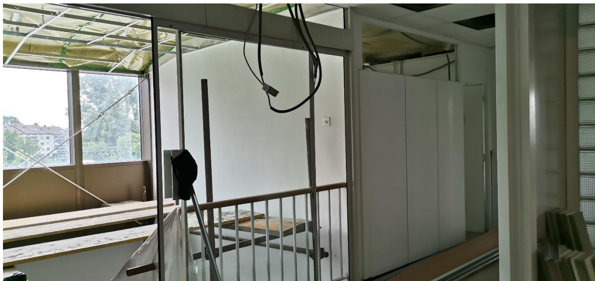
Stopnišče in hodnik v času obnove.
