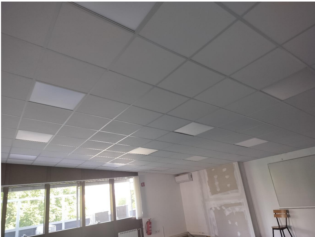
Učilnica 4 po stropni obnovi pred pleskanjem sten.
