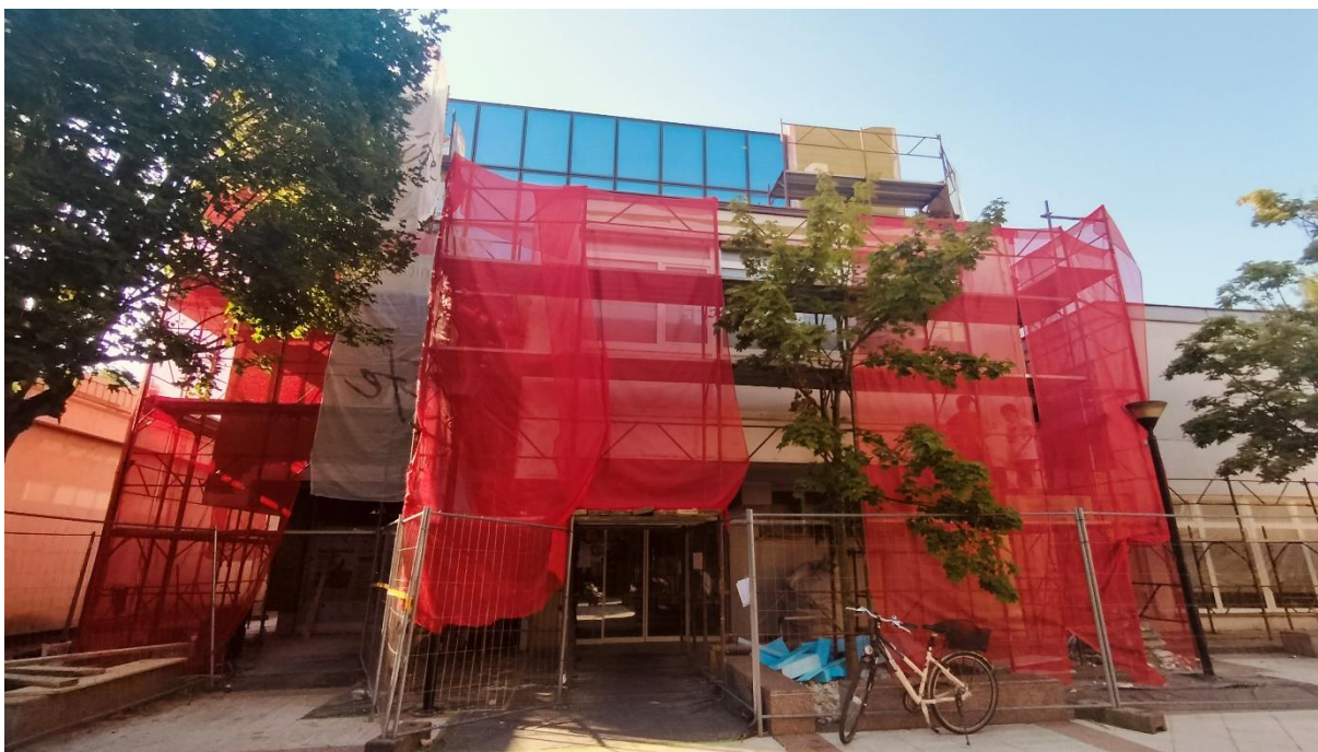
Potek zunanje obnove.
