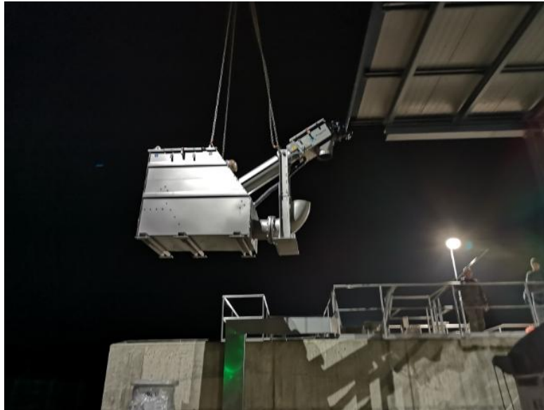
Slika: Montaža novih finih gabelj
