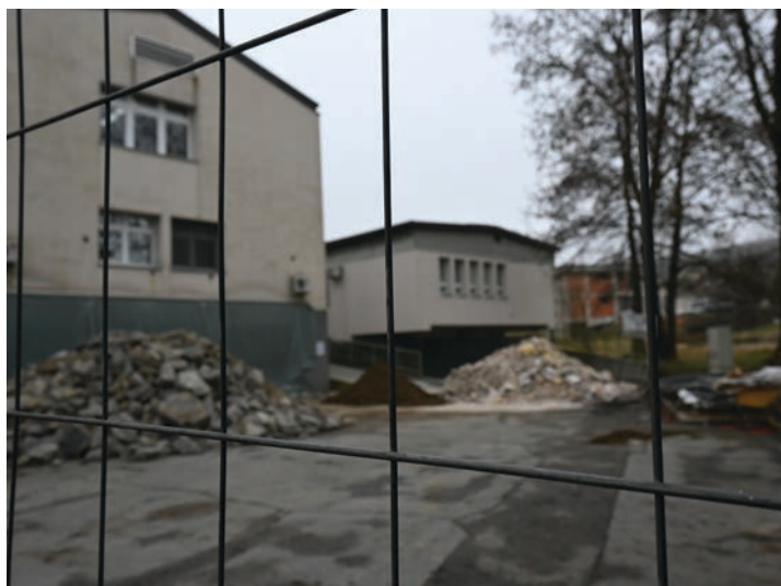
Trenuten izgled izgradnje laboratorija
