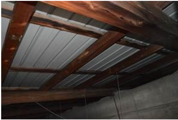
Notranjost strešne konstrukcije telovadnice ↑
