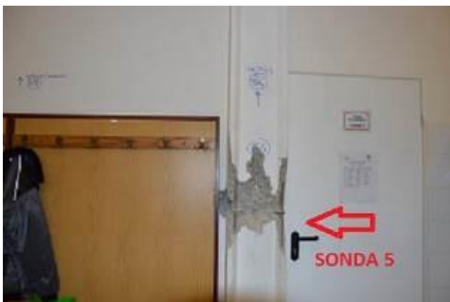
Sonda 5 vmesnega stebra telovadnice v pritličju ↑
