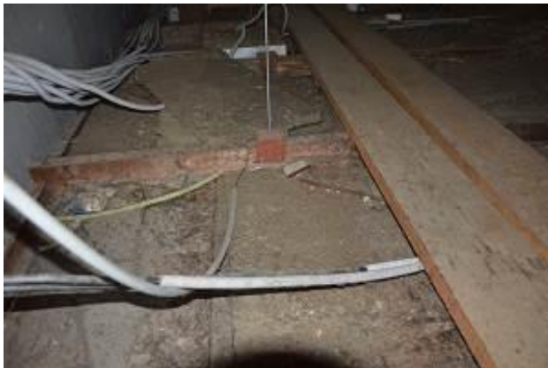
Notranjost strešne konstrukcije telovadnice ↑ (vidna vešala spodnje konstrukcije/obloge ter termoizolacija le 7 cm)
