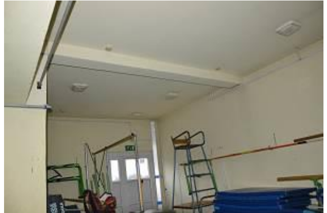
Pogled na del aneksa v pritličju JV del ↑
