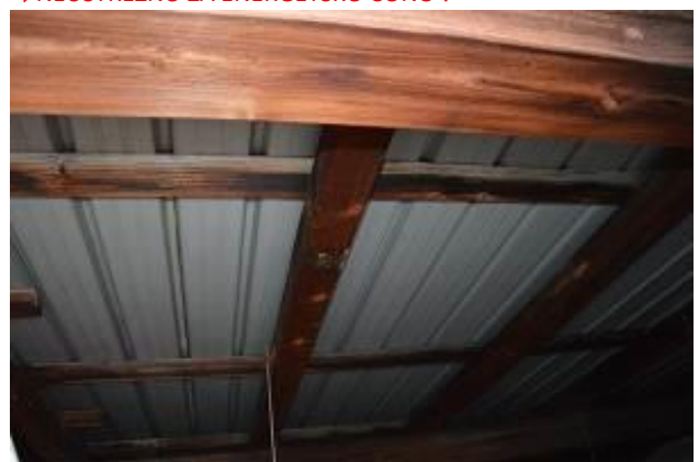
Notranjost strešne konstrukcije telovadnice ↑
