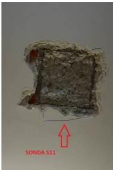
Sonda S11 gredni nosilec v stropu aneksa nad etažo ↑ (druga linija stebrov gledano iz Z smeri)
