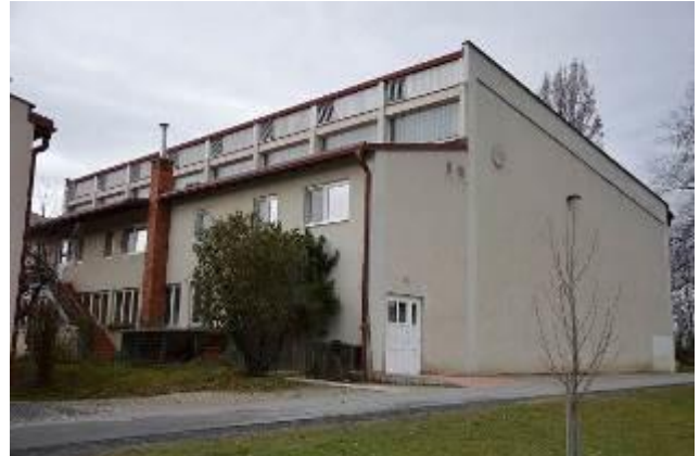
južna/levo in vzhodna/desno fasada ↑
