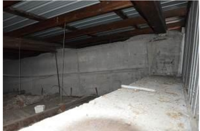
Notranjost strešne konstrukcije telovadnice ↑
