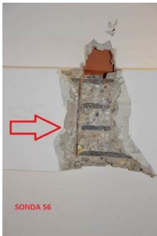
Sonda 6 gredni nosilec aneksa/strop pritličja ↑
