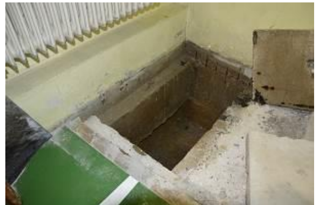
Sonda kanalete v SV vogalu telovadnice-pritličje ↑
