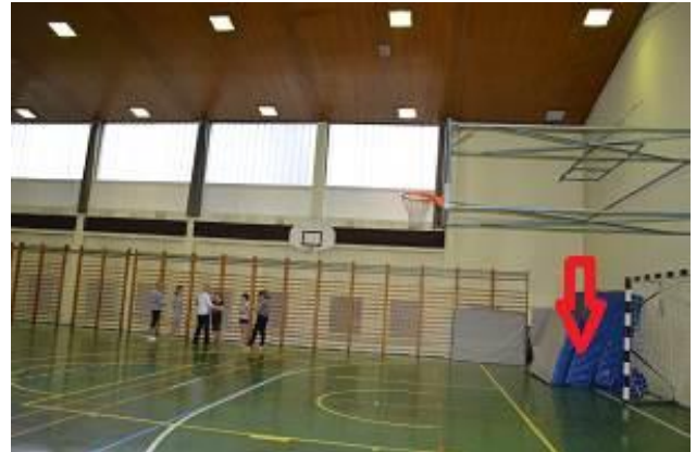
Sonda kanalete v SV vogalu telovadnice-pritličje ↑
