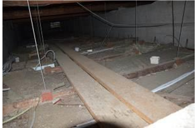
Notranjost strešne konstrukcije telovadnice ↑ (vidna vešala spodnje konstrukcije/obloge ter termoizolacija le 7 cm)
