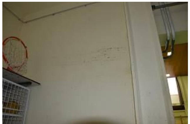
Pogled na vmesni steber telovadnice/desno iz aneksa v pritličju JV dela ↑
