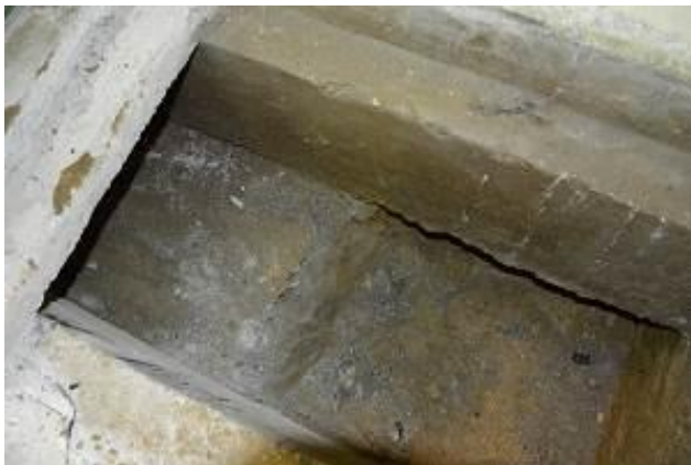
Sonda kanalete v SV vogalu telovadnice-pritličje ↑
