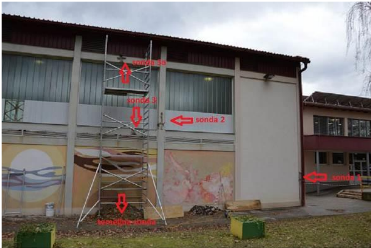
Pogled na severno fasado dela telovadnice in položaj sondaž ↑
