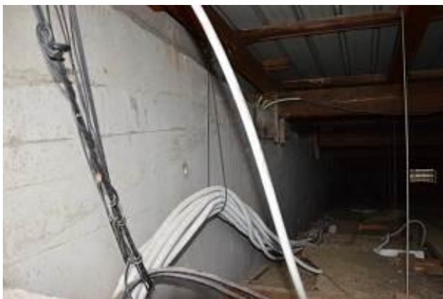
Notranjost strešne konstrukcije telovadnice ↑
