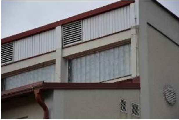
Pogled na del J fasade ↑
