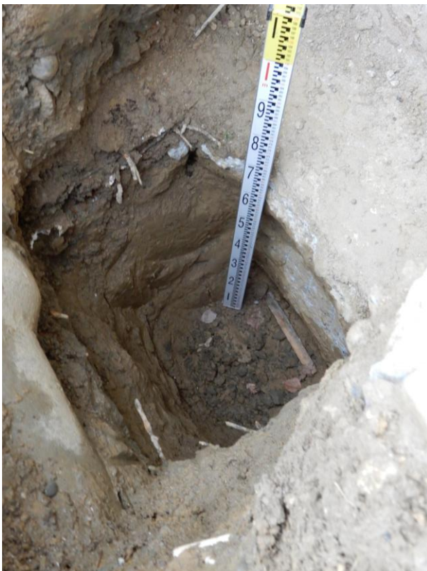
Sondažni izkop S-2 – ob JZ delu južne fasade objekta
