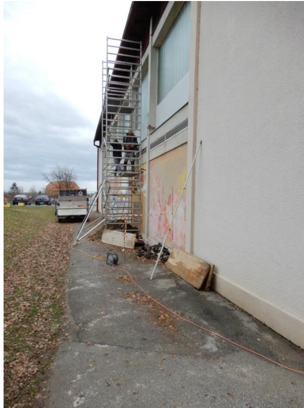
Severna fasada telovadnice – pogled od zahoda – lokacija S-1 (Foto 12.12.2017)
