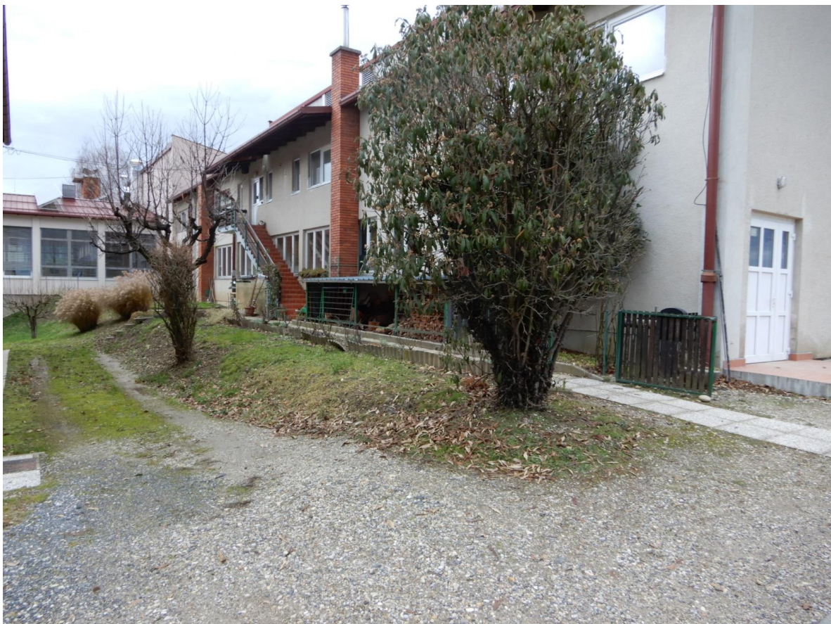
Južna fasada telovadnice – pogled od vzhoda (Foto 12.12.2017)
