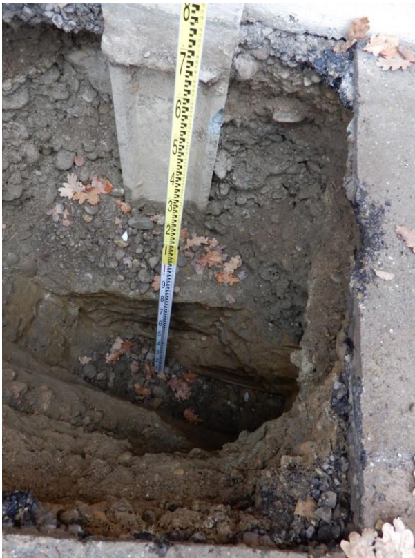
Sondažni izkop S-1 – SZ del severne fasade objekta
