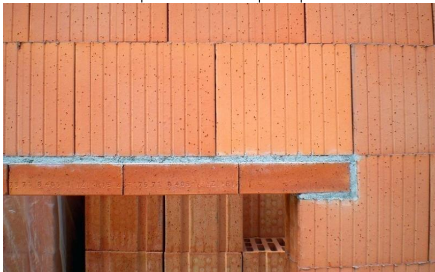
Slika – pravilna vzdava opečne preklade
