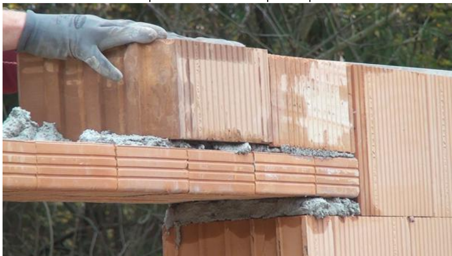
Slika – pravilna vzdava opečne preklade
