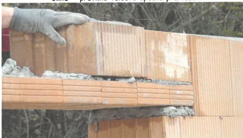
Slika – pravilna vzdava opečne preklade
