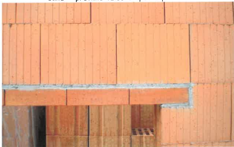
Slika – pravilna vzdava opečne preklade
