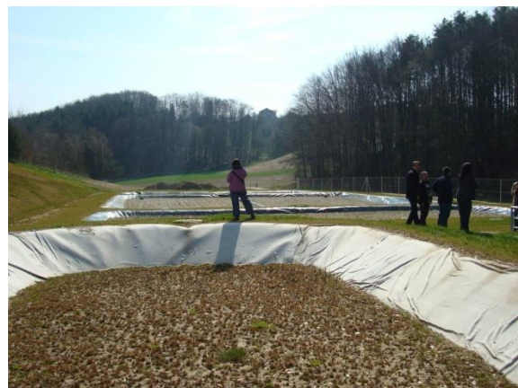
Slika 13: Nova RČN Sveti Tomaž, 500 PE
