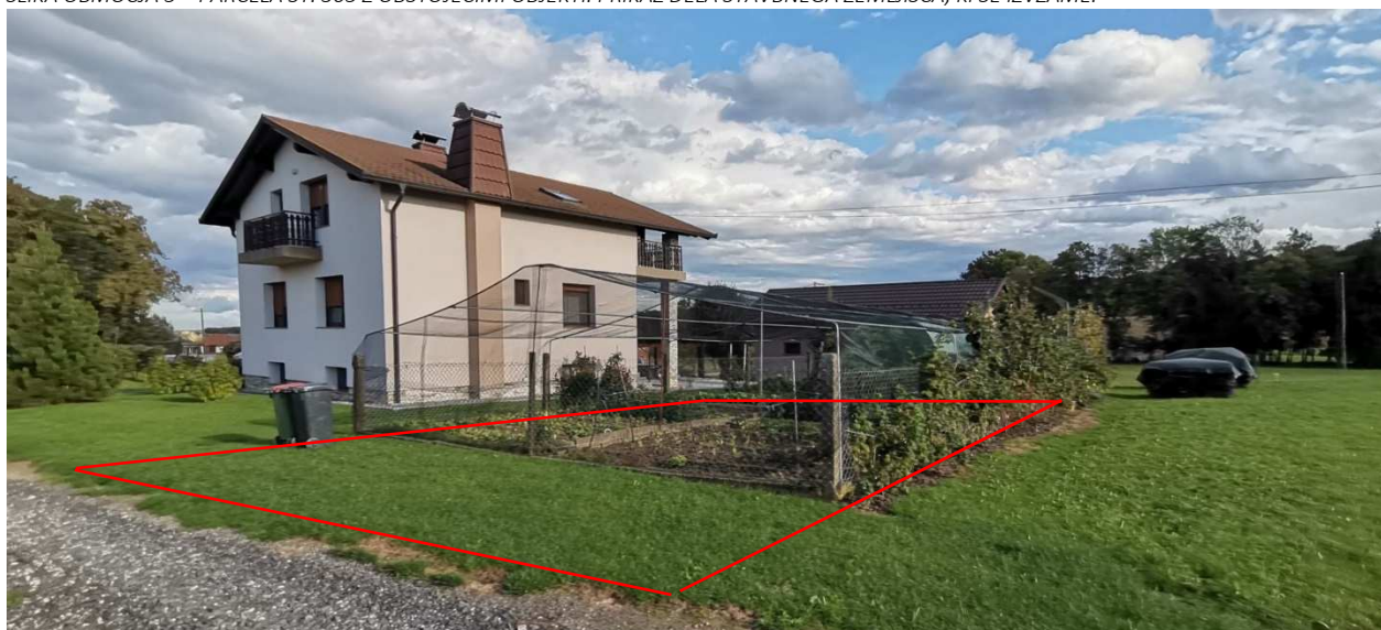
SLIKA OBMOČJA 5 – PARCELA ŠT. 305 Z OBSTOJEČIMI OBJEKTI. PRIKAZ DELA STAVBNEGA ZEMLJIŠČA, KI SE IZVZAME.
