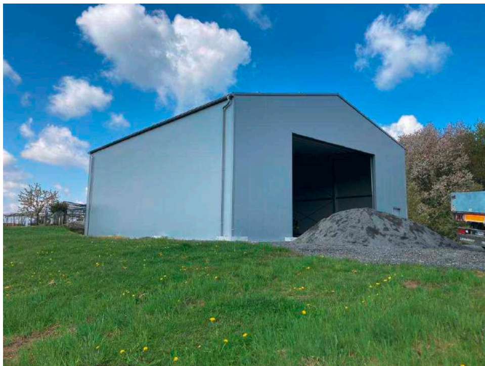
Slika 10: Prikaz nezahtevnega objekta, ki je še do nedavnega stal na območju obstoječega stavbnega zemljišča, katero je predmet razširitve na območje LP.
