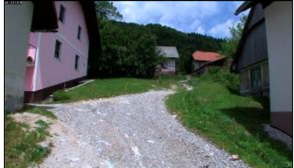
Slika 4.17: Neprimerno vozišče (primer 2)
