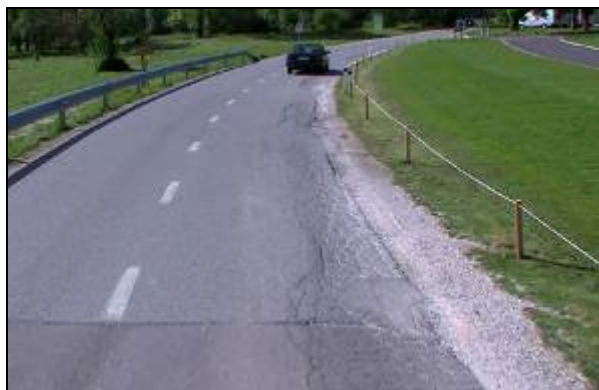
Slika 4.8: Udarna jama v nastajanju
