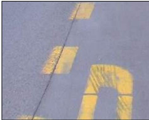
Slika 4.2: Razpoke - Vzdolžna razpoka
