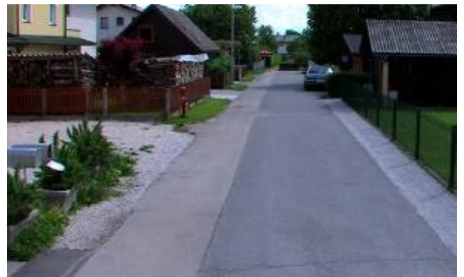
Slika 4.7: Krpe - Krpa narejena z zasekom pravokotno na smer vožnje z ravnimi robovi
