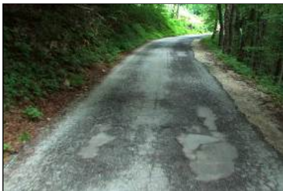
Slika 4.6: Krpe - Deformirano hladno krpanje
