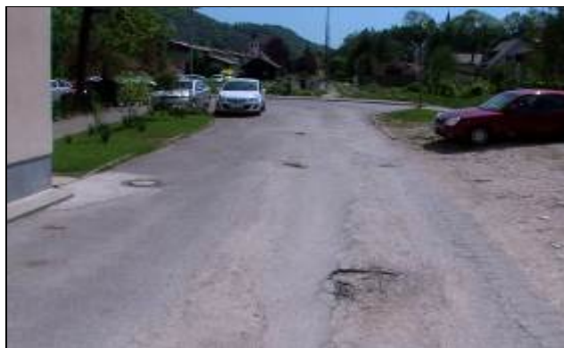
Slika 4.9: Udara jama globoka nad 5 cm premera
