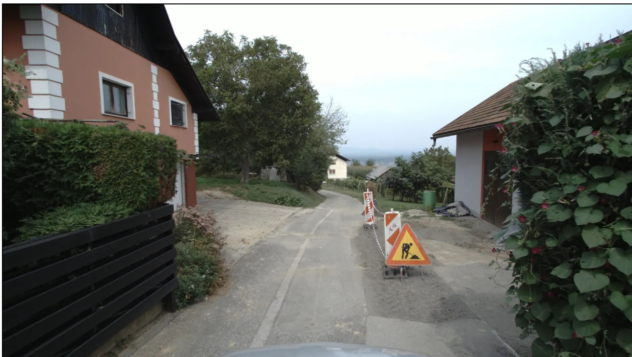
Slika 4.21: Primer opombe Gradbišče
