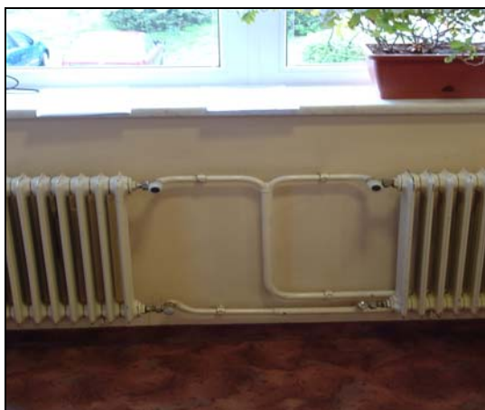
Slika 4: Klasični ventili na ogrevalih in okenski okvirji (starost 30 let)
