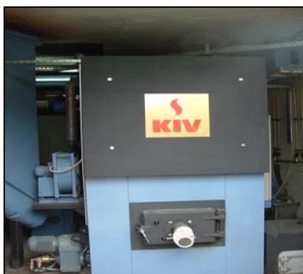
Slika 9: 500 kW kotel in silos za shranjevanje lesnih ostankov
