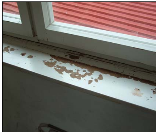
Slika 4: Klasični ventili na ogrevalih in okenski okvirji (starost 30 let)
