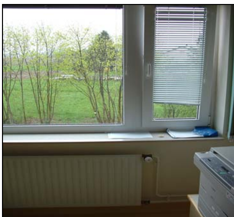
Slika 7: Termostatski ventili, nova okna in novi kotel
