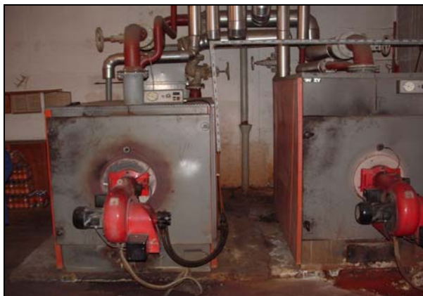
Slika 5: Kurilna naprava (brez avtomatskega reguliranja)
